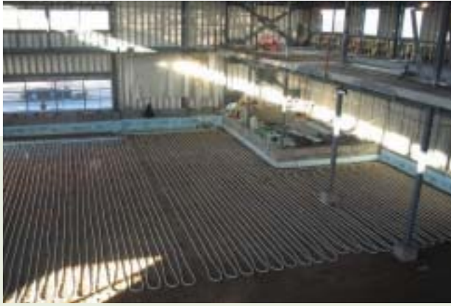
Installation du rang supérieur de la réserve thermique.
