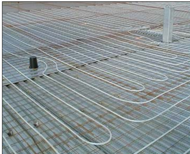
Image 2 : Coordination de percements pendant l'installation des tuyaux
